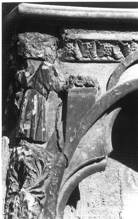
Fig. 137. Bourges, Saint-Étienne, face antérieure du contrefort droit du portail Saint-Ursin, détail.
