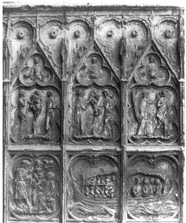
Fig. 221. Auxerre, cathédrale, façade occidentale, portail nord, soubassement.
