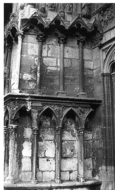
Fig. 40. Bourges, Saint-Étienne, façade occidentale, portail Saint-Ursin, ébrasement gauche.
