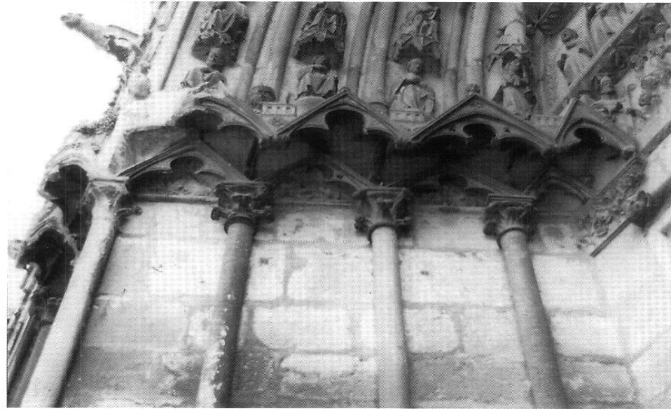
Fig. 17. Bourges, Saint-Étienne, façade occidentale, portail Saint-Ursin, ébrasement gauche.
