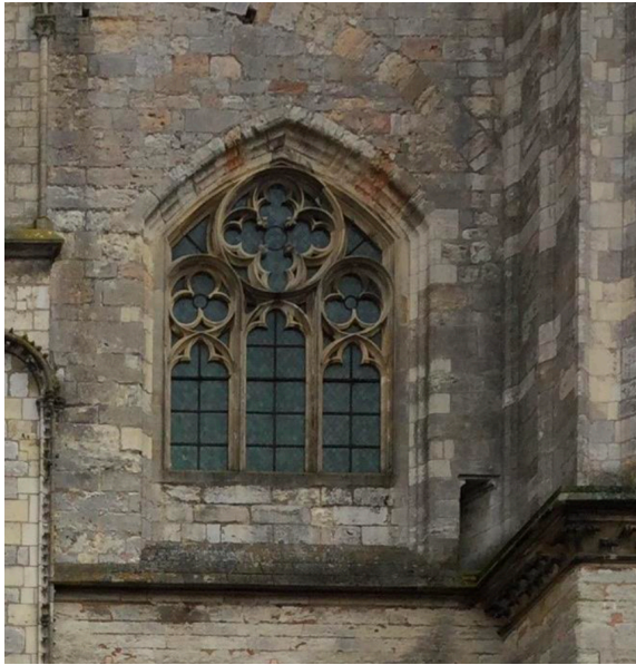
Fig. 10 : Détail de la fenêtre sur la face ouest du pilier-boutant de la cathédrale de Bourges (C. Briand)
